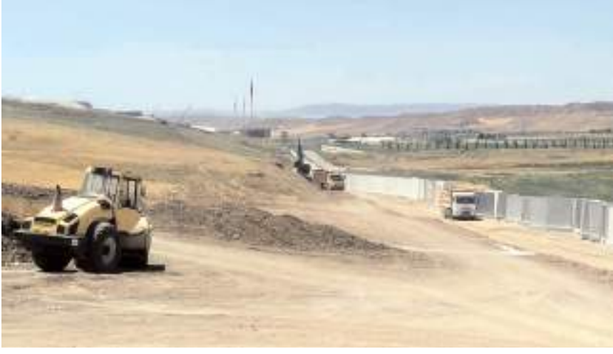
Sungurlu OSB'de yapılması planlanan jandarma hizmet binasının inşaat çalışmaları başladı.
