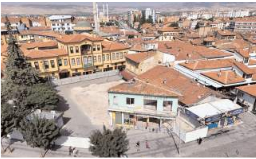
Velipaşa Hanı ile Saat Kulesi arasındaki alanda ikinci etap çalışmaları başladı.
