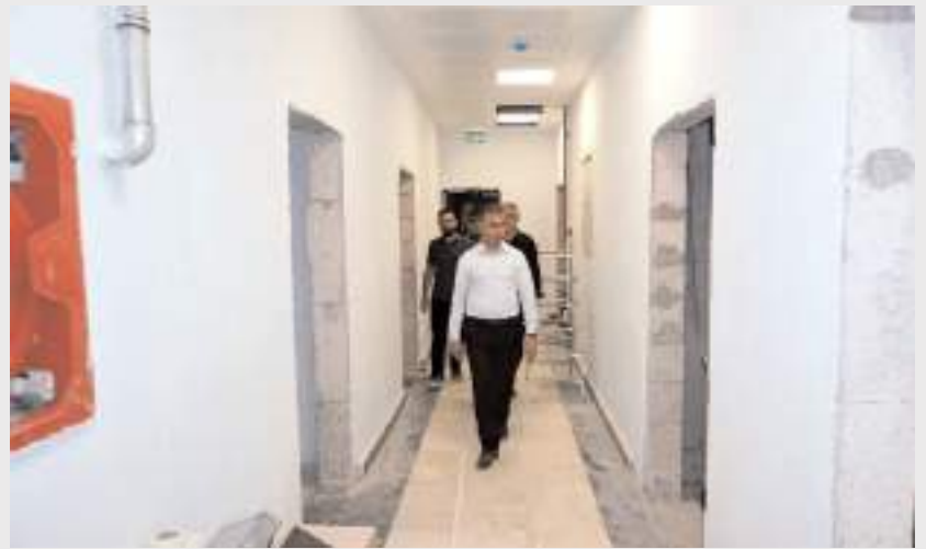
Kaymakam Duman, inşaatta incelemelerde bulundu.
