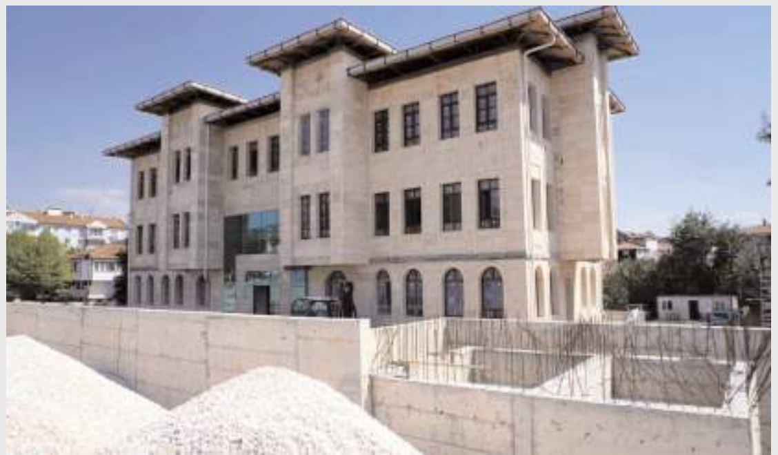
Yeni Emniyet Müdürlüğü binasında çalışmalar devam ediyor.
