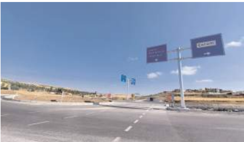
Yeni tamamlanan dönel kavşak, sürücülerde tedirginliğe yol açtı.
