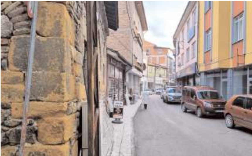
Dr. Pertevbey Sokak'ta yol bakım ve onarım çalışması yapılacak.
