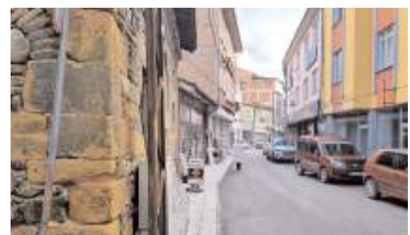
Dr. Pertevbey Sokak'ta yol bakım ve onarım çalışması yapılacak.
