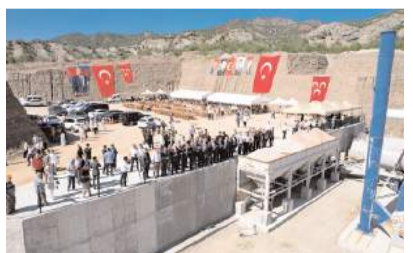
Tesis saatte 100 ton sıcak asfalt üretecek kapasiteye sahip.
