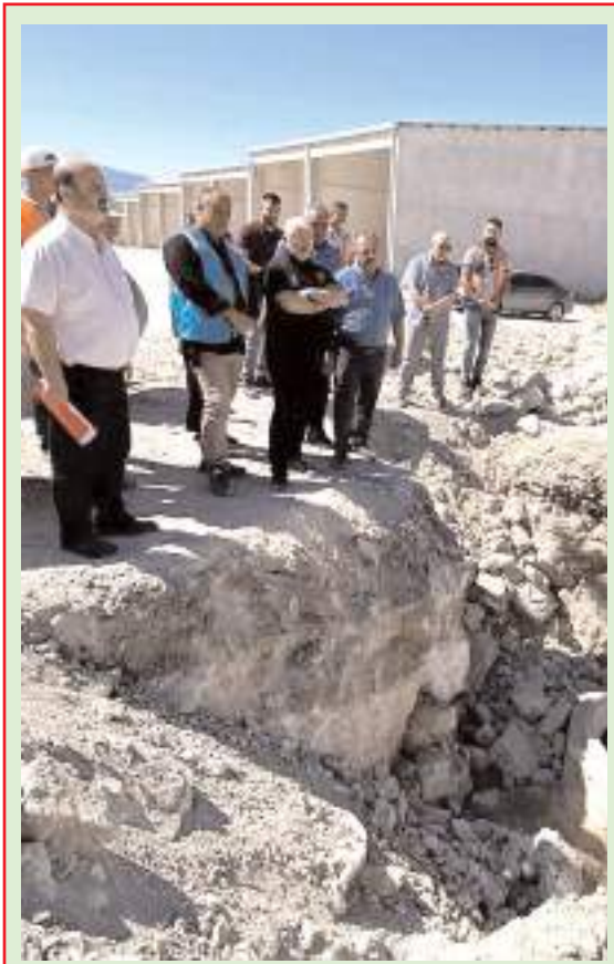
Zanaatkarlar Yapı Kooperatifi Sanayi Sitesi'nin altyapısı belediye tarafından yapıldı.
