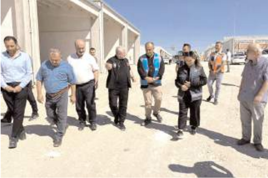
Başkan Aşgın, ağustos ayında Zanaatkarlar Yapı Kooperatifi Sanayi Sitesi'nde başlatılan altyapı çalışmalarını incelerken...
