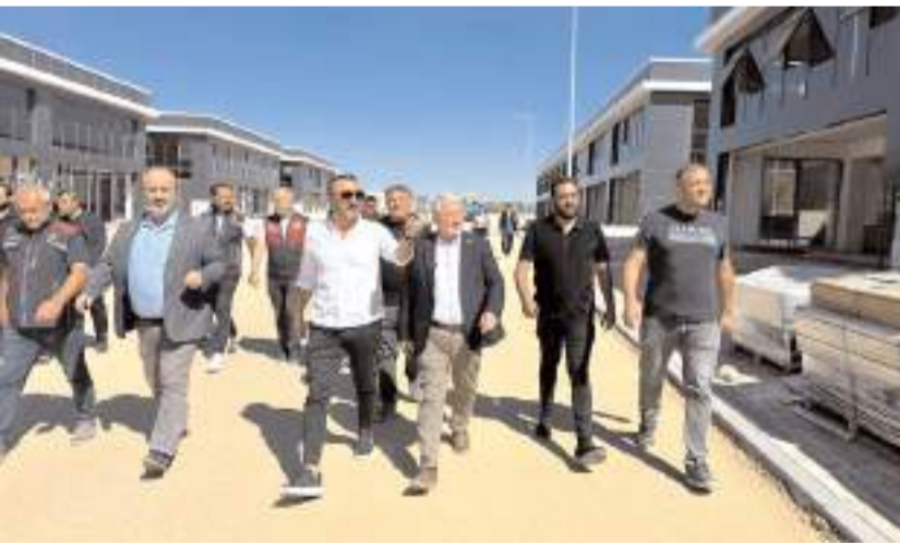
Toplam 106 işyerinden oluşan sitenin inşaatında son düzenlemeler yapılıyor.
