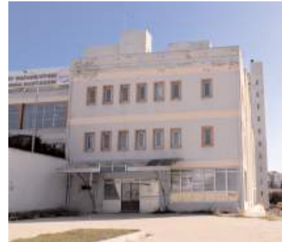
Eski Devlet Hastanesi C Blok yıkılıp yeniden yapılacak.
