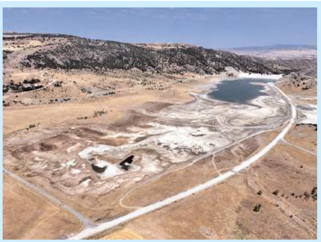
Barajlarda toplam doluluk oranı yalnızca %3,49 seviyesine indi.
