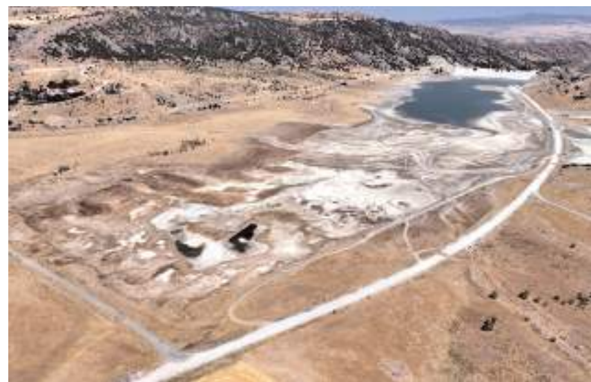
Barajlarda toplam doluluk oranı yalnızca %3,49 seviyesine indi.
