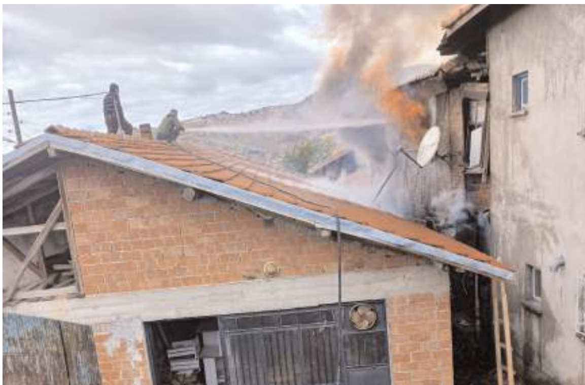
Yangın çevre binalara sıçramadan söndürüldü.
