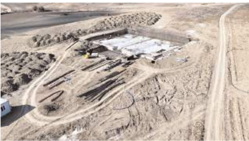
İlçeye yeni 5000 m3'lük su deposu yapılıyor.
