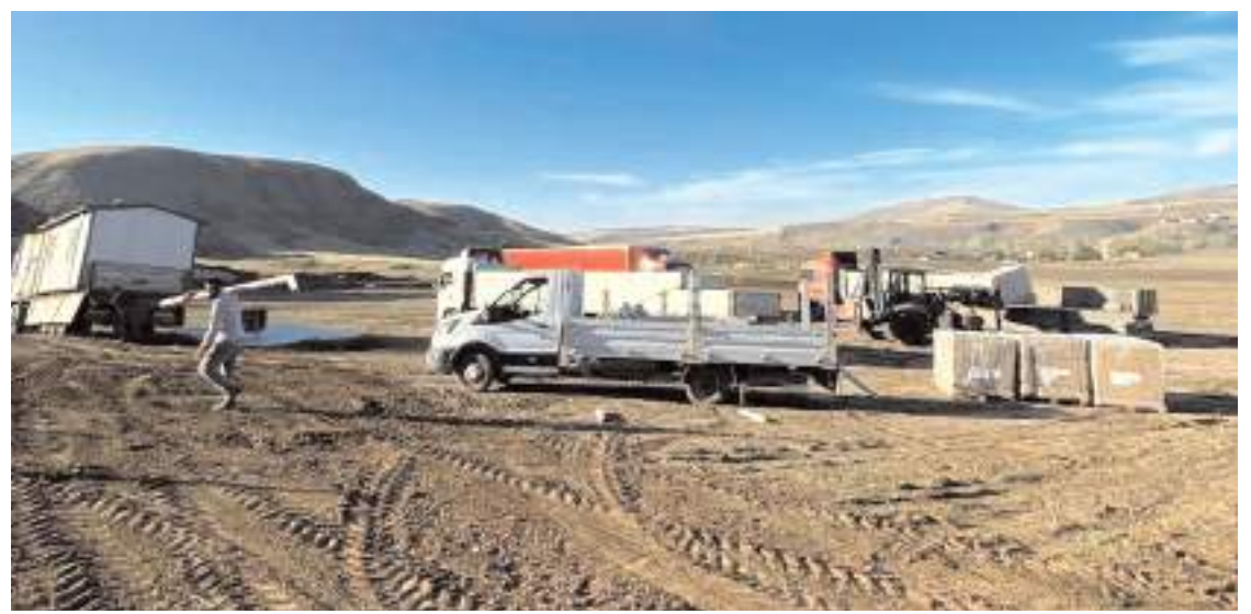
Güneş Enerji Santrali (GES) projesinin yapım işi başladı.
