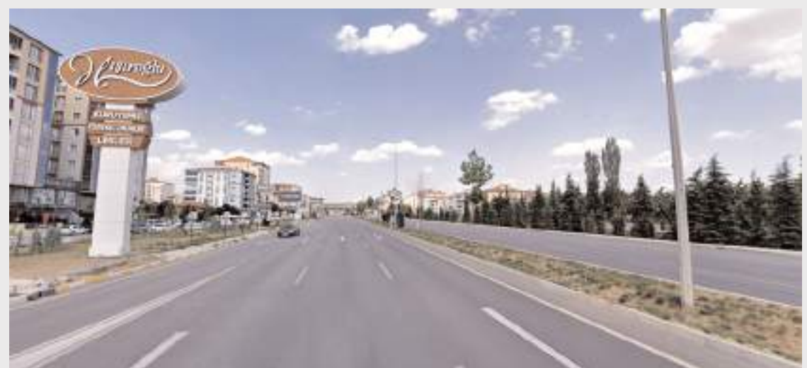
Akşemseddin Kavşağı ile Osmancık Caddesi üstgeçiti arasındaki orta refüjde korkuluk bulunmuyor.
