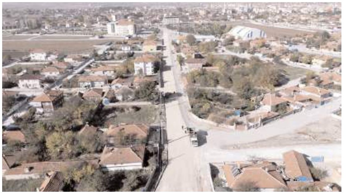
Alaca Belediyesi ekipleri ilçede asfaltlama çalışmalarına devam ediyor.
