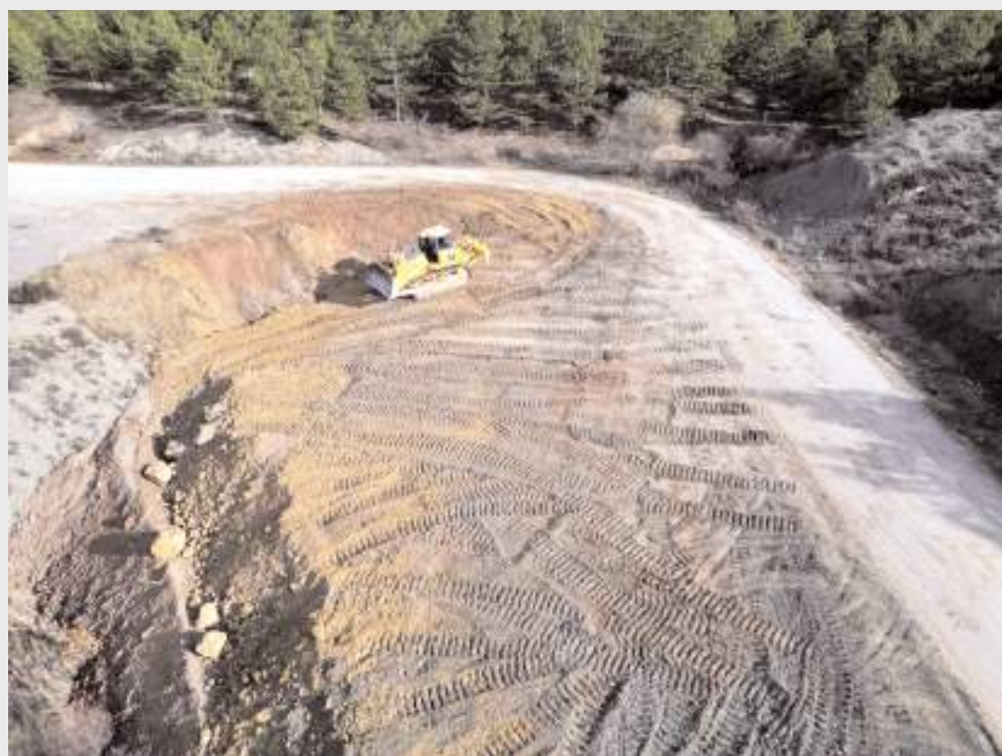
Belediye Çomar Barajında 2.kısım yol genişletme çalışmalarına başladı.
