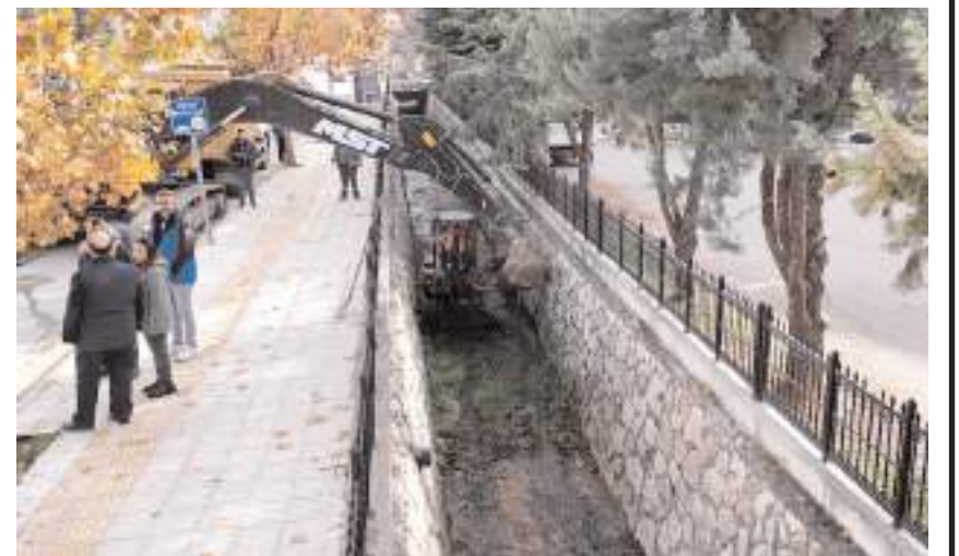
Ot ve çöplerden arındırıldıktan sonra dere içerisine 500 metreküp beton dökülecek.
