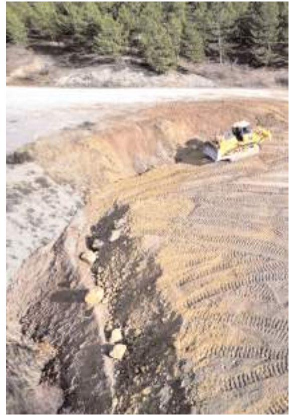
Belediye Çomar Barajında 2.kısım yol genişletme çalışmalarına başladı.
