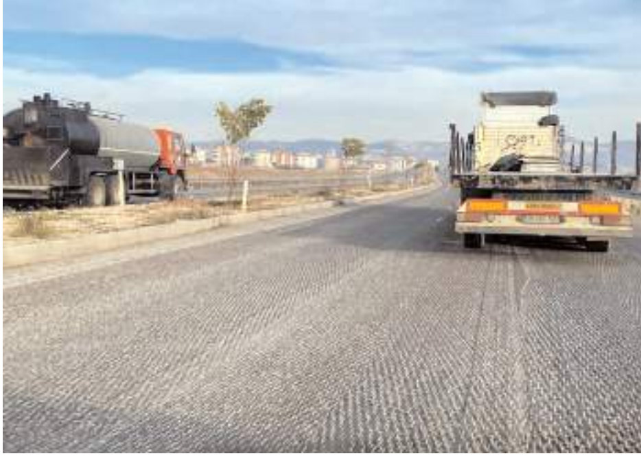
Yolun bozulan yerlerinde onarım çalışması yapılıyor.
