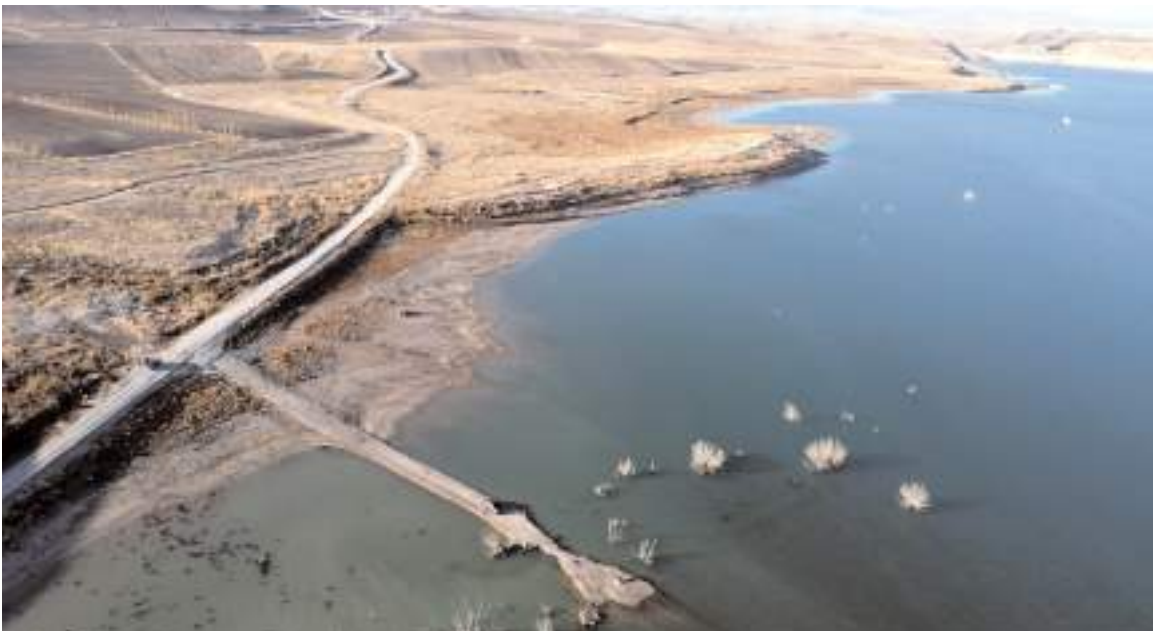
Koçhisar Barajı'nda suların çekilmesiyle, baraj havzasında bulunan eski Çorum-Yozgat kara yolunun bir bölümü de ortaya çıktı.
