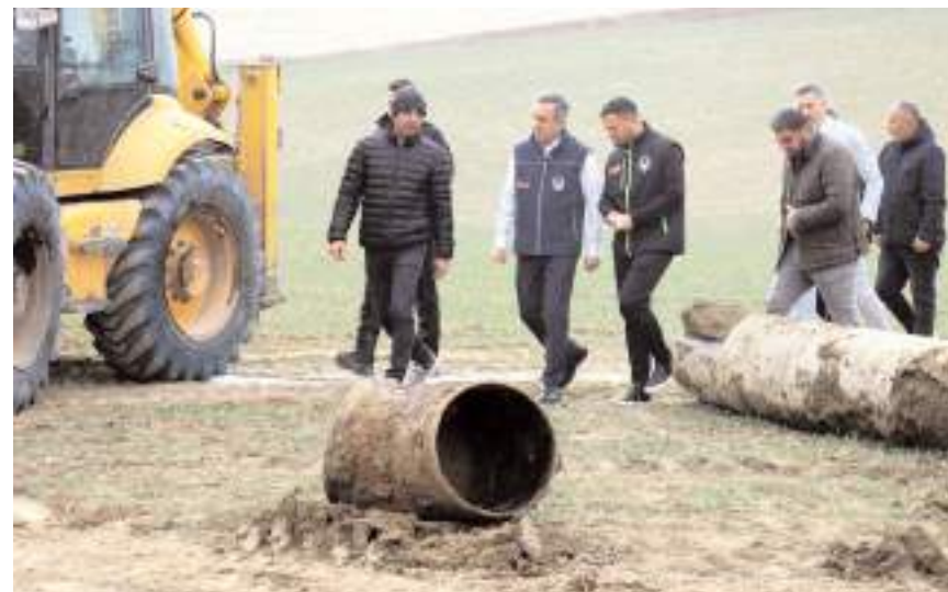
Yaklaşık 10 kilometrelik asbestli boru hattı, daha sağlıklı ve dayanıklı polietilen borularla değiştiriliyor.
