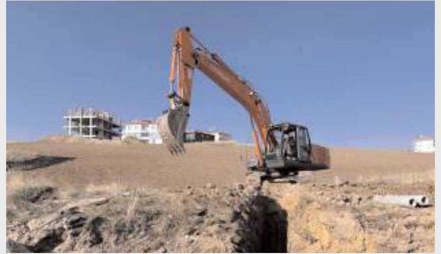
Çalışma kapsamında 260 metre uzunluğunda atık su hattı yapılacak.
