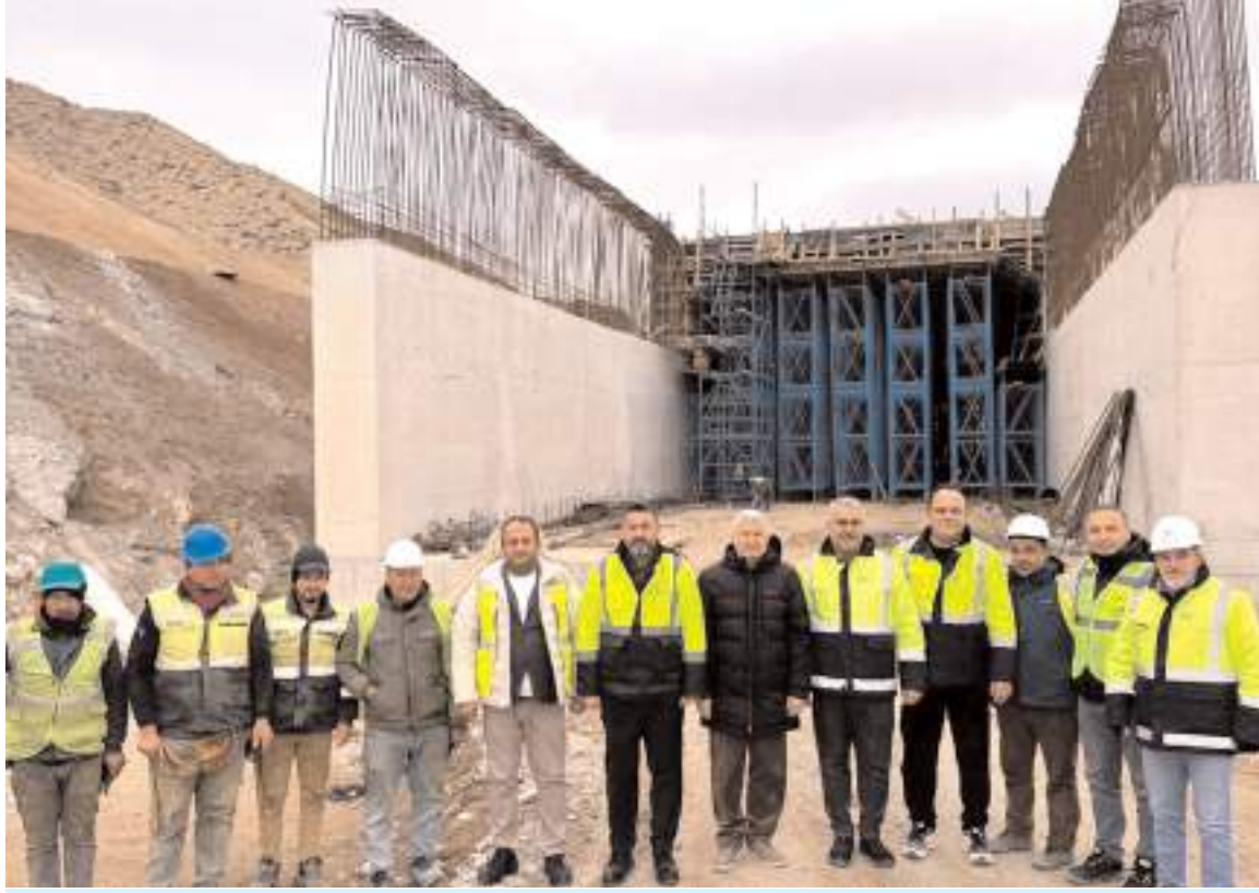
Demiryolu çalışmaları 7/24 devam ediyor.
