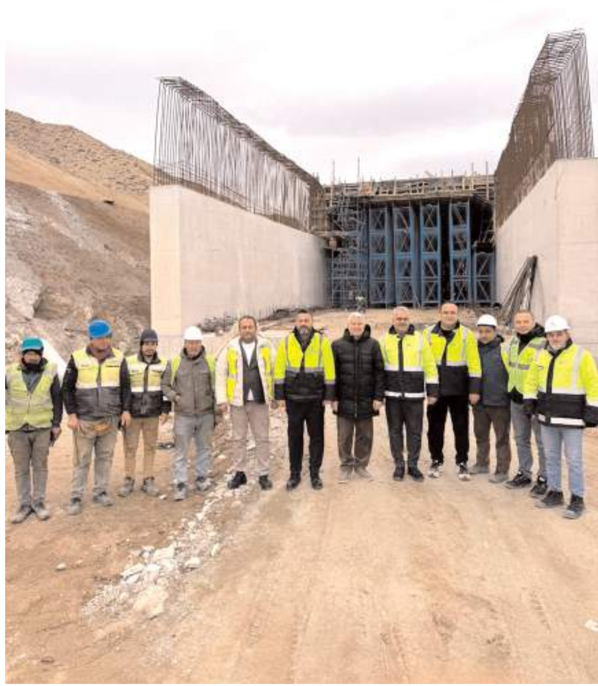
Demiryolu çalışmaları 7/24 devam ediyor.
