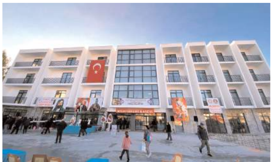
3 bloktan oluşan Rıza Şehri Projesinin misafirhane ve aşevini kapsayan ilk bloğu tamamlanarak açıldı.
