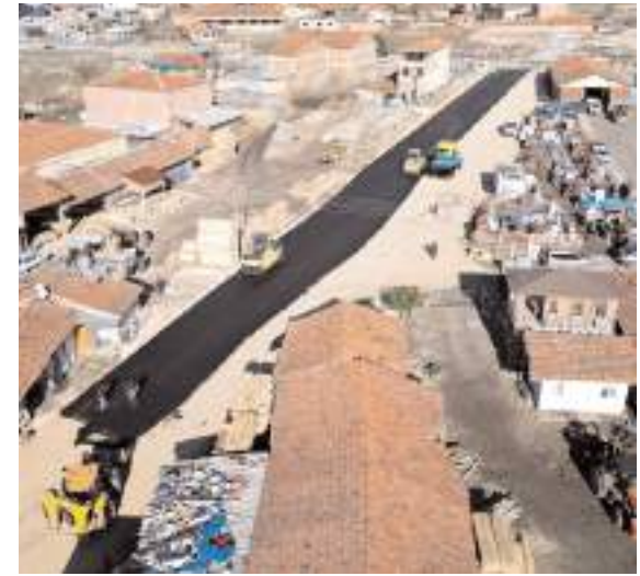
Necmettin Erbakan Caddesi ile İskilip Caddesi'ni birbirine bağlayan Tarım Caddesinde asfalt çalışmaları tamamlandı.
