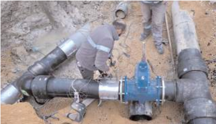
Melikgazi Depo çıkışından Nadik Depo hattı üzerinden Bahabey bölgesindeki depolara bağlantı yapıldı.
