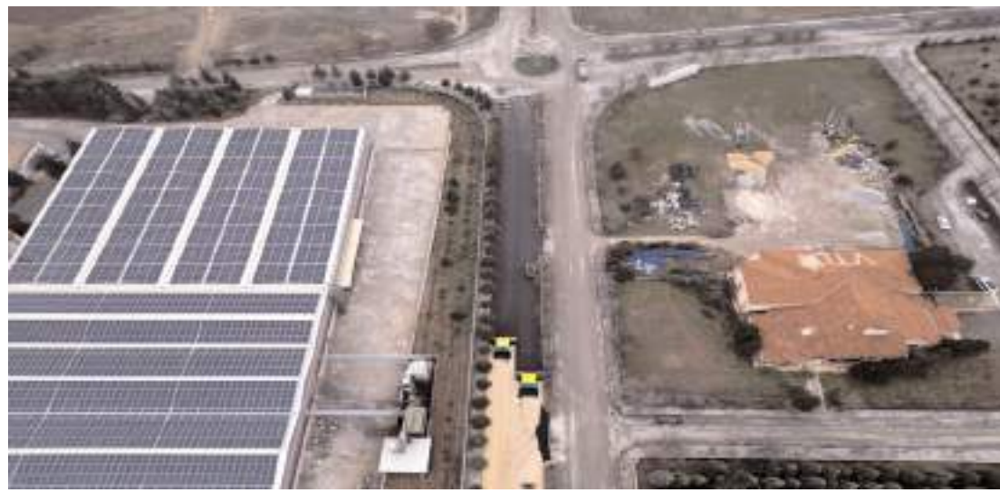
Çorum Belediyesi, Organize Sanayi Bölgesi’nde asfalt çalışmalarına devam ediyor.
