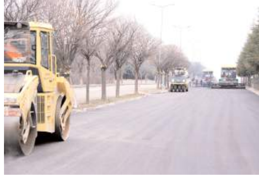
OSB’de bulunan Salih Aydın Bulvarı’nda asfalt öncesi mekanik çalışmalarının ardından 1700 ton asfalt serimi gerçekleştirildi.
