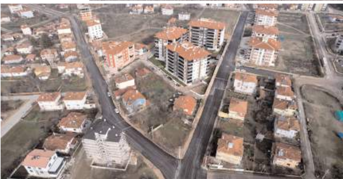
Belediye ekipleri Eymir, Gemici, Gürleyik, Şenyurt ve Koyunbaba mahallelerindeki cadde ve sokaklarda asfalt çalışmalarını tamamladı.
