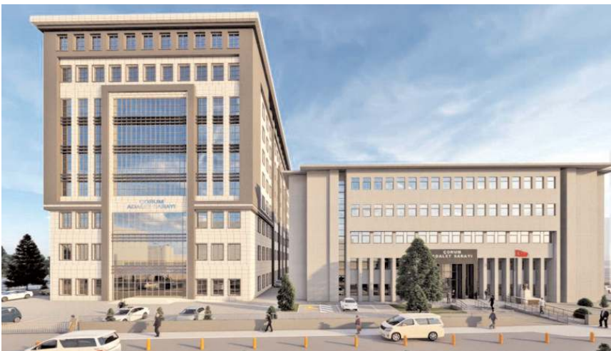
Ek binada 23 adet duruşma salonunun yer aldığı belirtildi.
