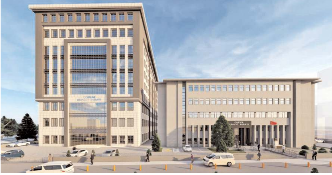
Ek binada 23 adet duruşma salonunun yer aldığı belirtildi.
