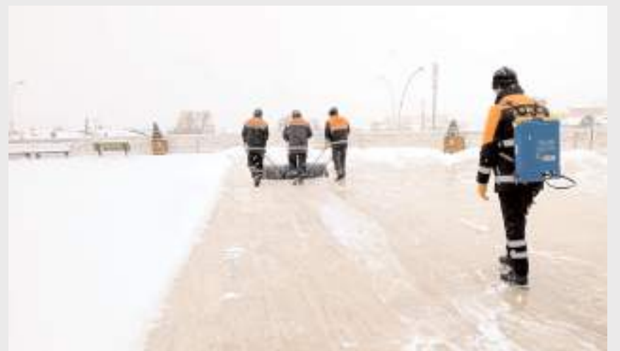
Kardan temizlenen yerlere özel solüsyon döküldü.
