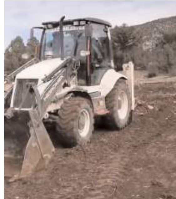
Ortaköy Belediyesi, baz istasyonunun kurulacağı yeri hazırladı.
