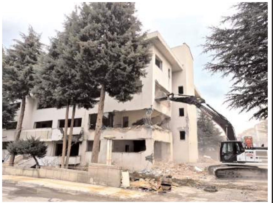
Yıkılan bina yerine Hasanpaşa Semt Polikliniği ve Fizik Tedavi Ünitesi inşa edilecek.
