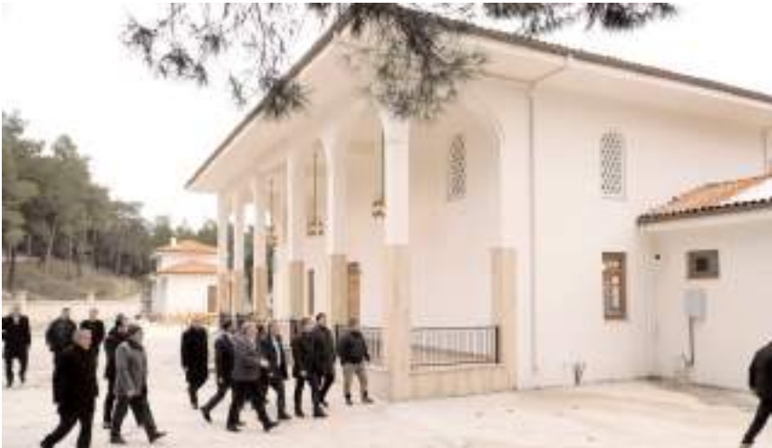
Mustafa Yiğittaşcı tarafından Koyunbaba Türbesi'nin yanına inşa edilen cami inşaatında sona yaklaşıldı.
