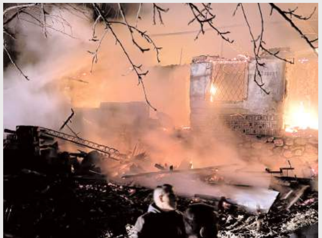
Yangın çevre binalara sıçramadan söndürüldü.
