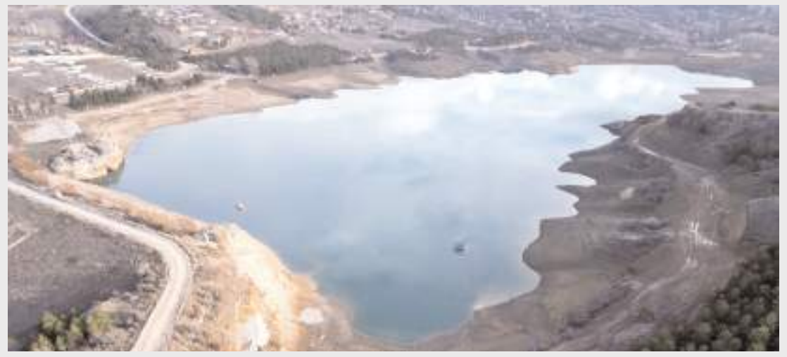
Çomar Barajında yol genişletme çalışmalarının ikinci etabı devam ediyor.
