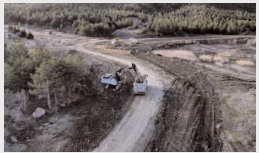
Çalışmalarda 1.750 metrelik alanda yol açma ve genişletme yapılacaktır.
