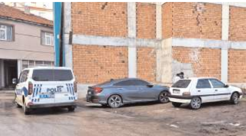
Olay Günhan Mahallesi'nde meydana geldi.
