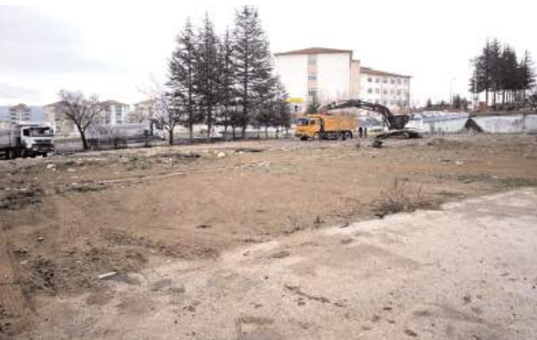
Okul inşaatının hafriyat çalışmaları başladı.
