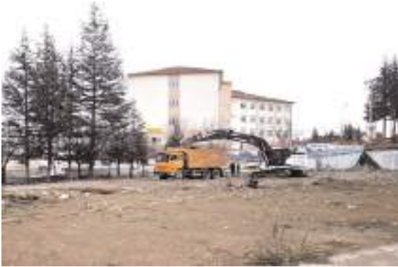
Okul inşaatının hafriyat çalışmaları başladı.
