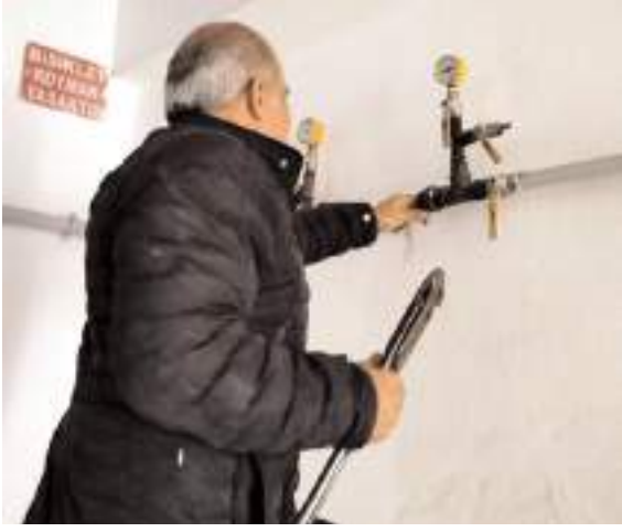
Yetkili teknik servis ekipleri bozulan doğalgaz sayaçlarını sökerek yenileriyle değiştirdi.
