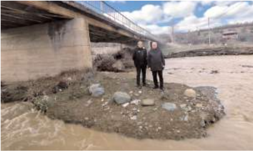
Köprünün yıkılarak yeniden yapılması hedefleniyor.
