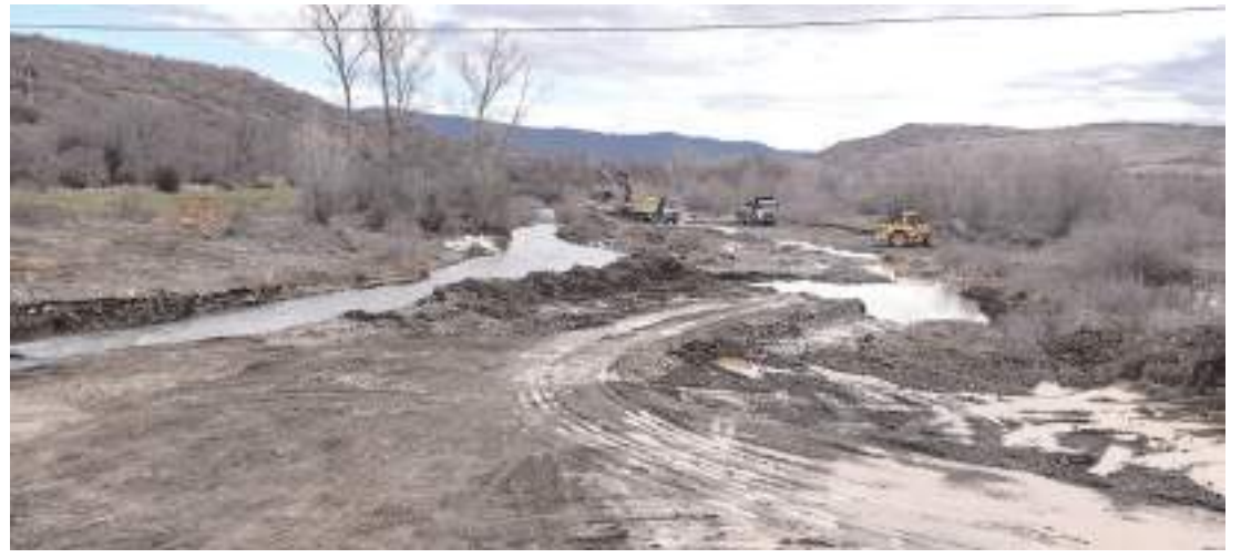
Yol yapılacak geçici köprü ile ulaşım açılacak.
