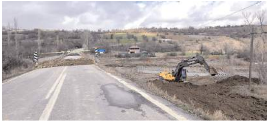
Hasar gören köprünün yerine yenisinin inşa edilmesi için çalışmalar sürüyor.
