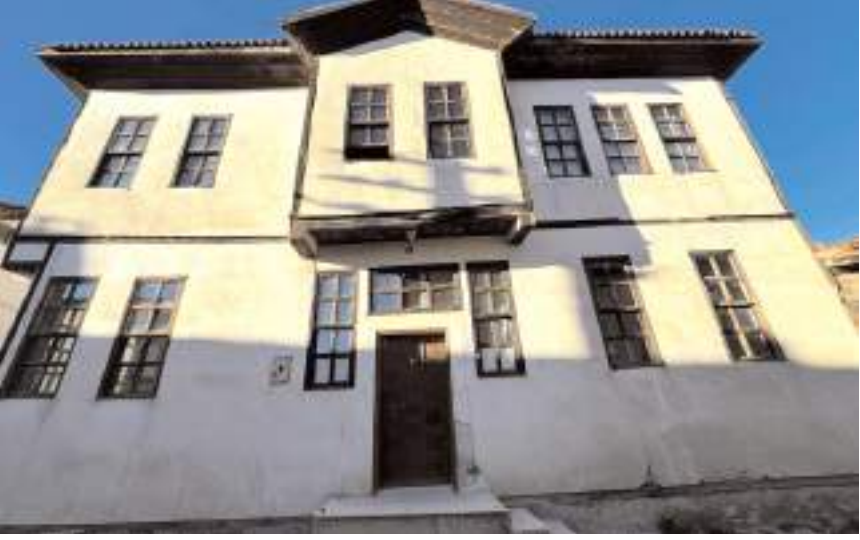
Proje kapsamında Fazlalar Konağı restore edilecek.
