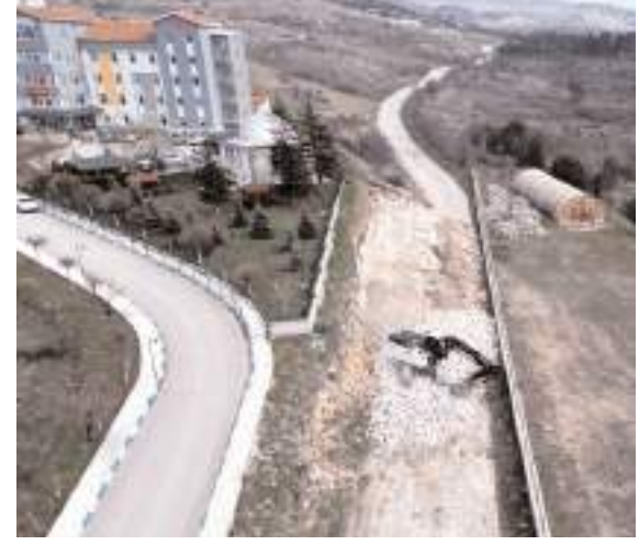
Kamile-Hacı Ahmet Akdağ Huzurevi yanında kalan yolda da genişletme çalışmaları başlatıldı.
