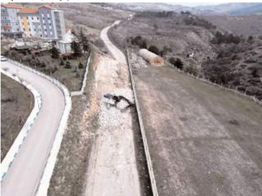
Kamile-Hacı Ahmet Akdağ Huzurevi yanında kalan yolda da genişletme çalışmaları başlatıldı.
