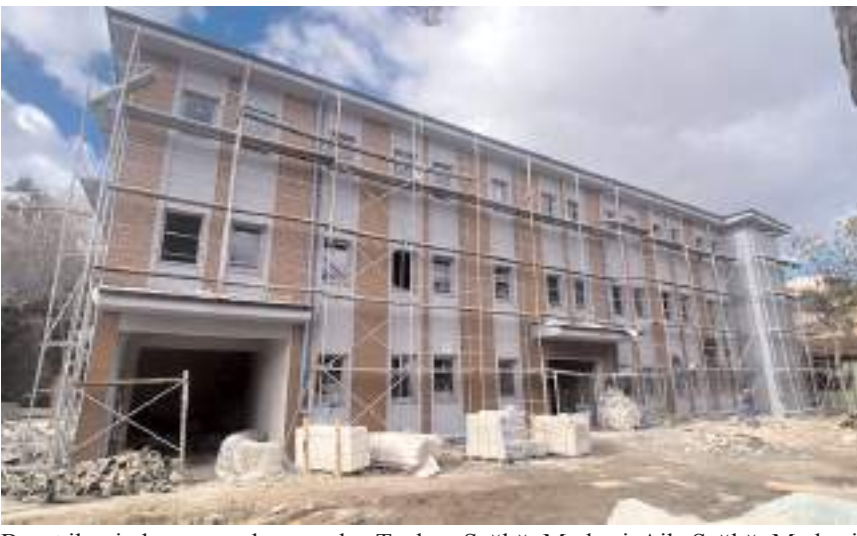
Bayat ilçesinde yapımı devam eden Toplum Sağlığı Merkezi, Aile Sağlığı Merkezi ve Acil Sağlık Hizmetleri İstasyonu inşaatında da incelemelerde bulunuldu.
