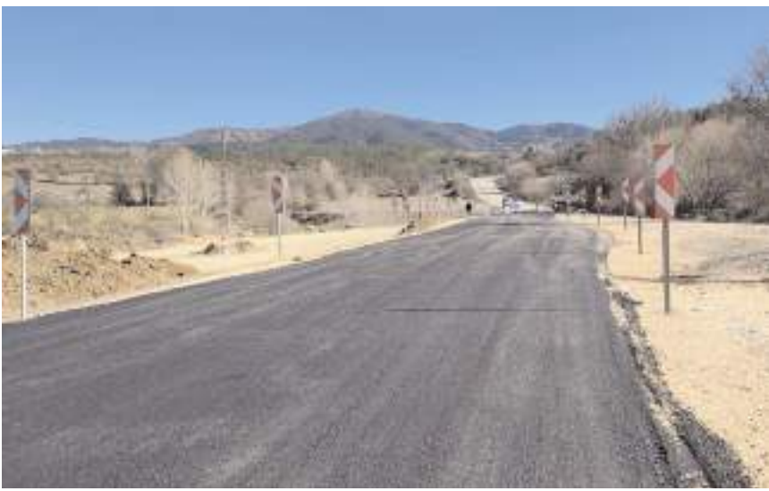
Yolun asfaltı atıldı.
