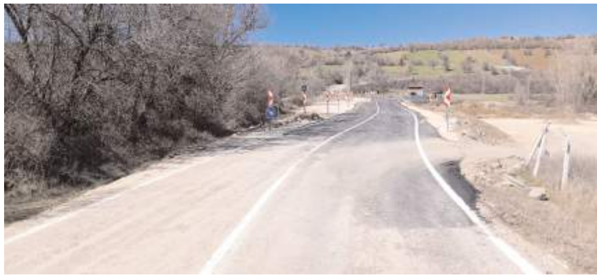
Ayağı yıkıldığı için kapatılan köprünün yanına servis yolu yapıldı.
