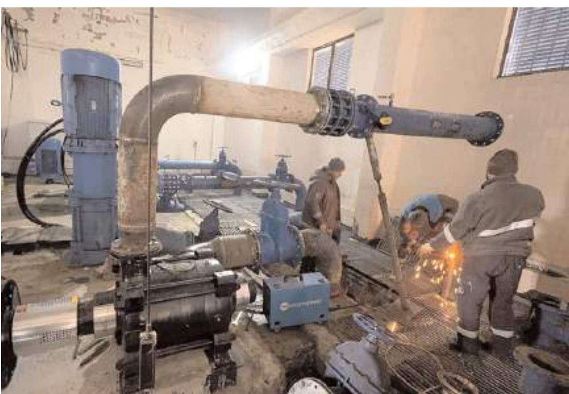
Eskice Pompa İstasyonu mevcut durumda ihtiyacın yaklaşık yüzde 30'unu karşılıyor.
