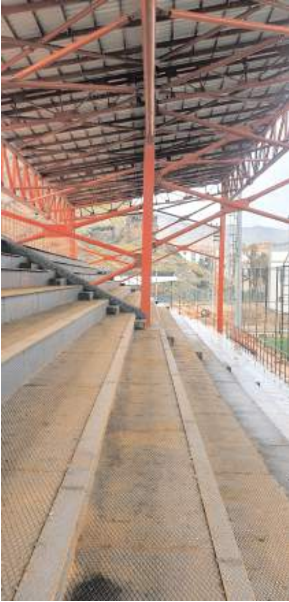
Tribün çatısı kısa olduğu için rüzgar olmadığı halde ilk üç basamak yağmur alıyor ve izlemek mümkün değil
