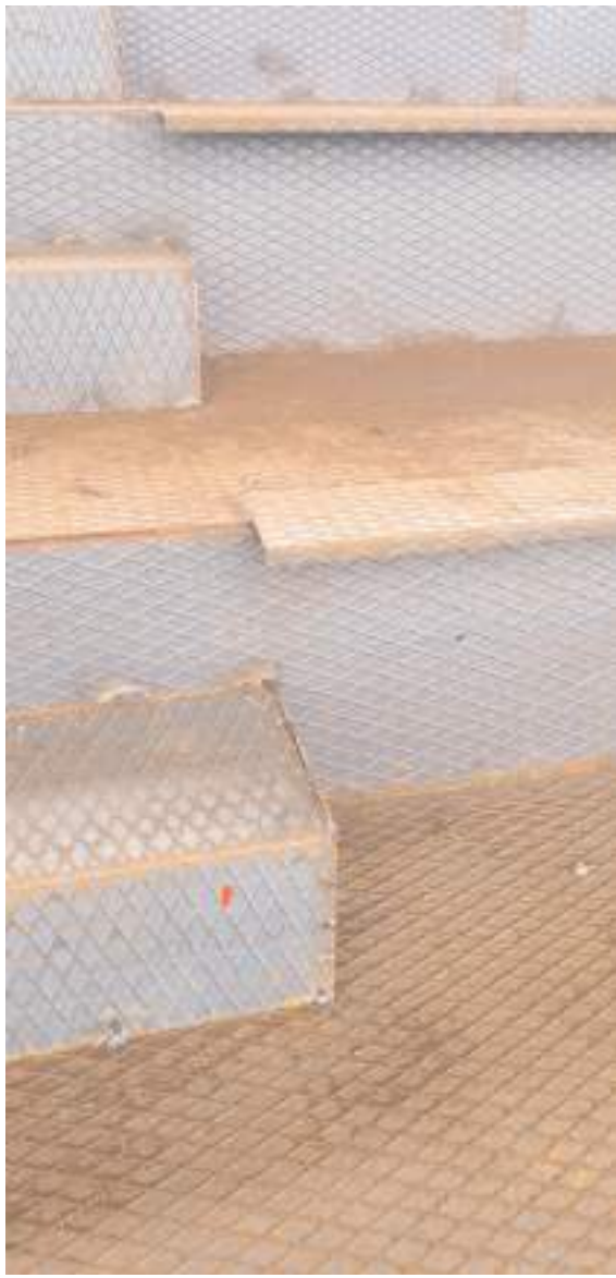
Tribündeki malzemeler daha kullnılmadan paslanmaya başladı ve yapılan ekler ise ortaya oldukça çirkin görüntüler çıkardı
