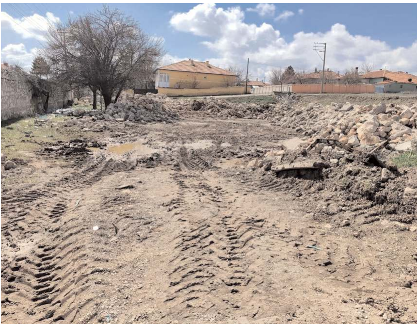
Yapı tehlike arz etmesi ve kötü görüntü oluşturması gerekçesiyle yıkıldı.
