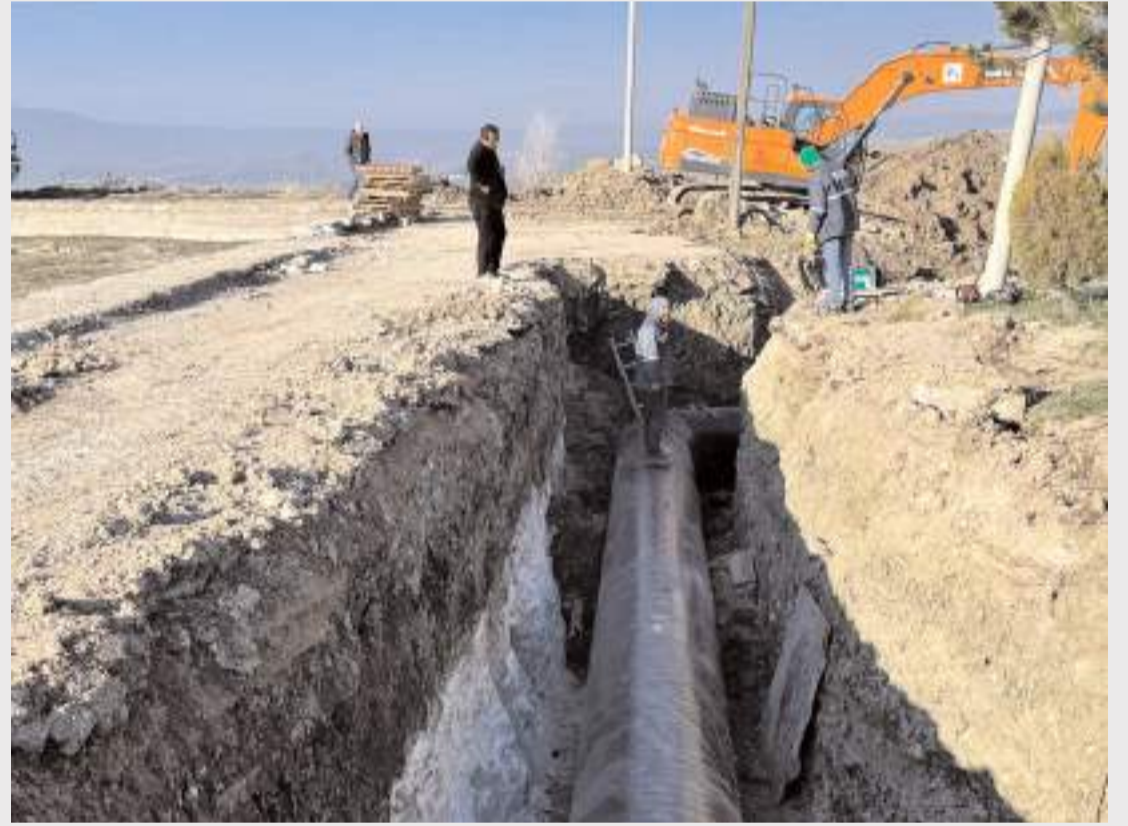
İçme Suyu Arıtma Tesisi ile 2. isale hattının bağlantısı yapıldı.
