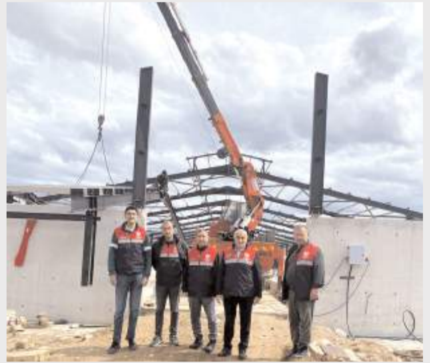
200 büyükbaş kapasiteli damızlık süt işletmesi inşaatında inceleme yapıldı.
