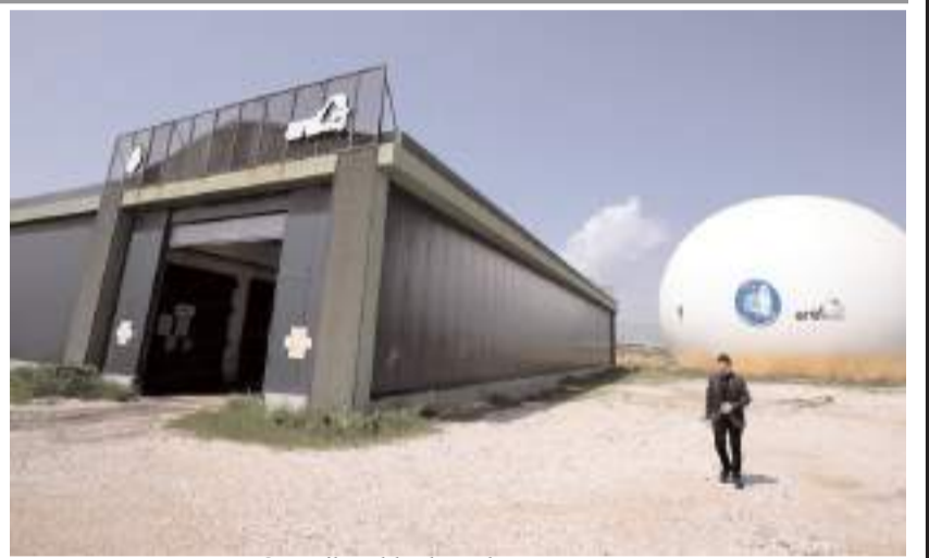
Organik atıklardan çıkan metan gazı, 50 bin metreküp kapasiteli balonda toplanıyor.
