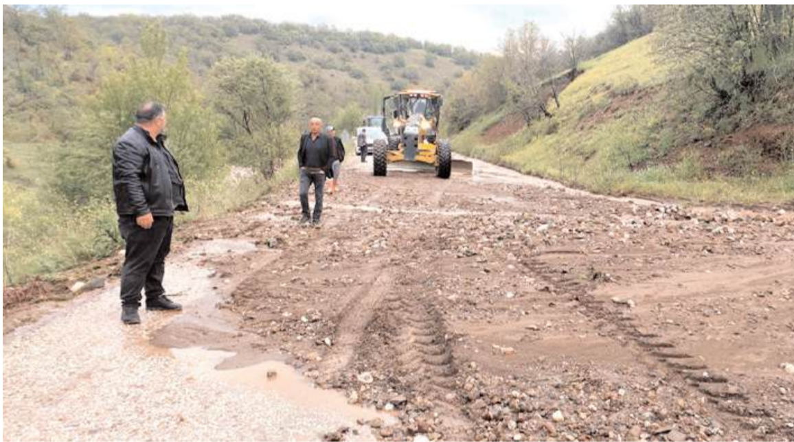
Hava şartları nedeniyle tahrip olan yollar onarılıyor.
