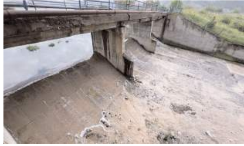
Baraj tamamen dolduğu için fazla su dolu savaktan mansap hattına akıyor.
