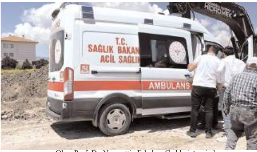
Olay, Prof. Dr. Necmettin Erbakan Caddesi üzerinde bulunan bir inşaat alanında meydana geldi.
