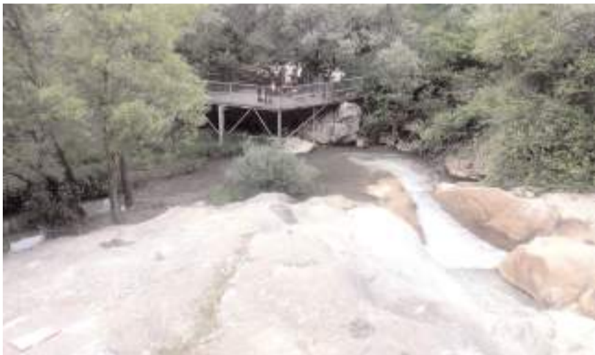
Olay, Boğazkale ilçesinde bulunan Hoşur Göleti'nde meydana geldi.
