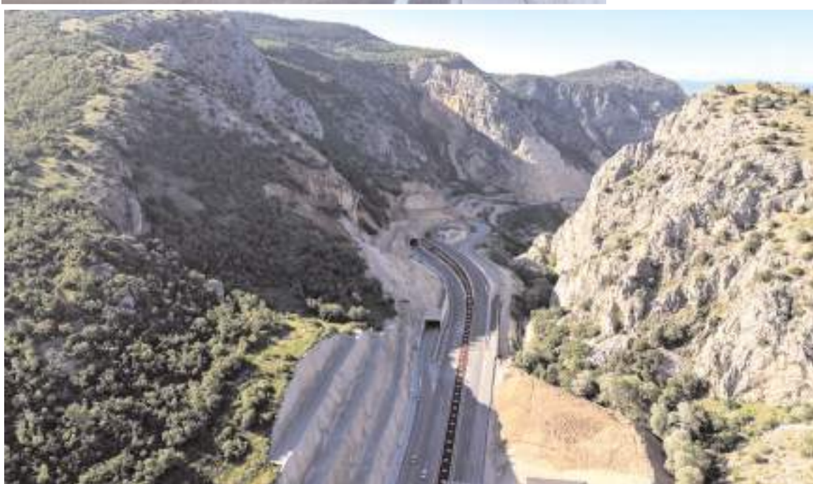
Kırkdilim Geçidi'ne toplam 4 bin 99 metrelik üç tünel inşa edildi.
