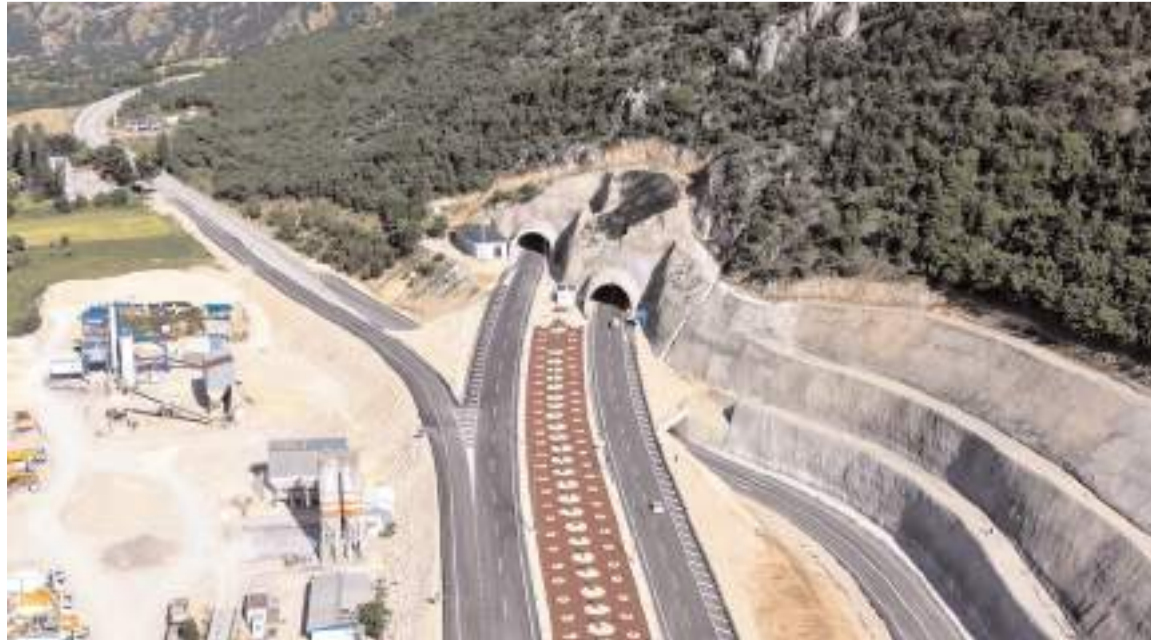
Tünellerden günlük ortalama 8 bin 300 araç geçti.
