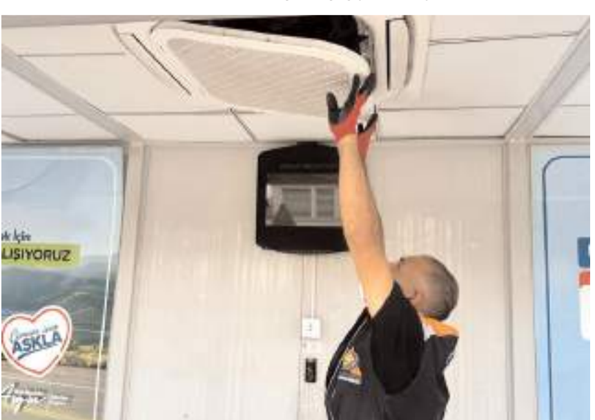
Duraklarda bulunan klima sistemlerinin bakımları da yapılıyor.
