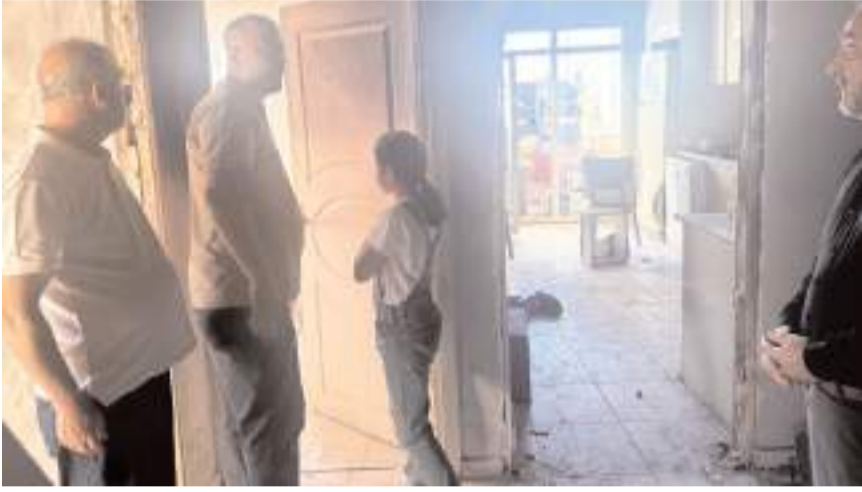
Yangında ev kullanılmaz hale geldi.
